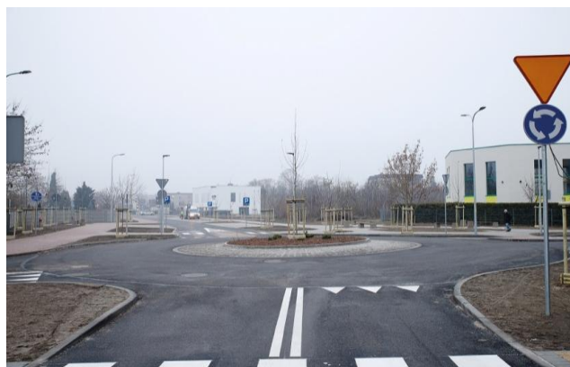
Zrealizowana inwestycja pn.: „Budowa, przebudowa ul. 68 Pułku Piechoty oraz przebudowa skrzyżowania na ul. 68 Pułku Piechoty, Zamyśłowskiego i Kutrzeby we Wrześni”.
