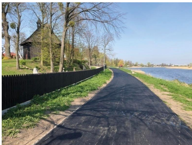
Rozbudowa ścieżki pieszo–rowerowej wokół zalewu dofinansowana ze środków Wielkopolskiego Regionalnego Programu Operacyjnego na lata 2014-2020.
