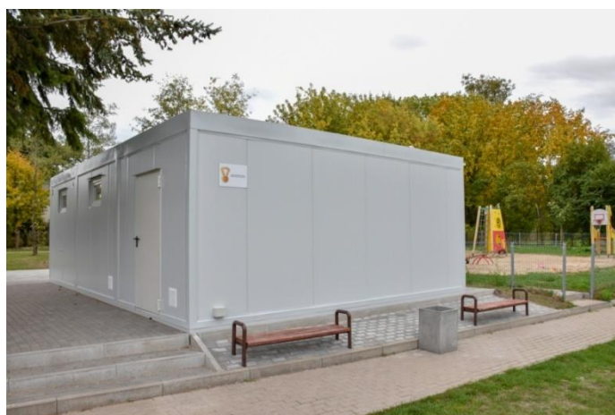
Zaplecze szatniowo-sanitarne w Bardzie.
