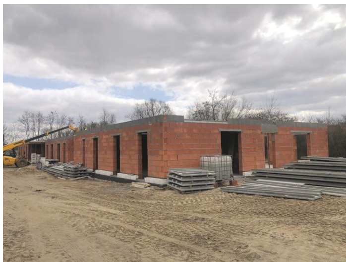
Budowa bloku wielorodzinnego przy ul. Pilskiej dofinansowana ze środków Banku Gospodarstwa Krajowego.
