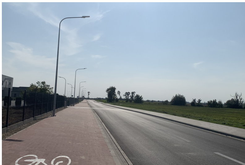
Nowo wybudowana droga łącząca ul. Paderewskiego i Działkowców
