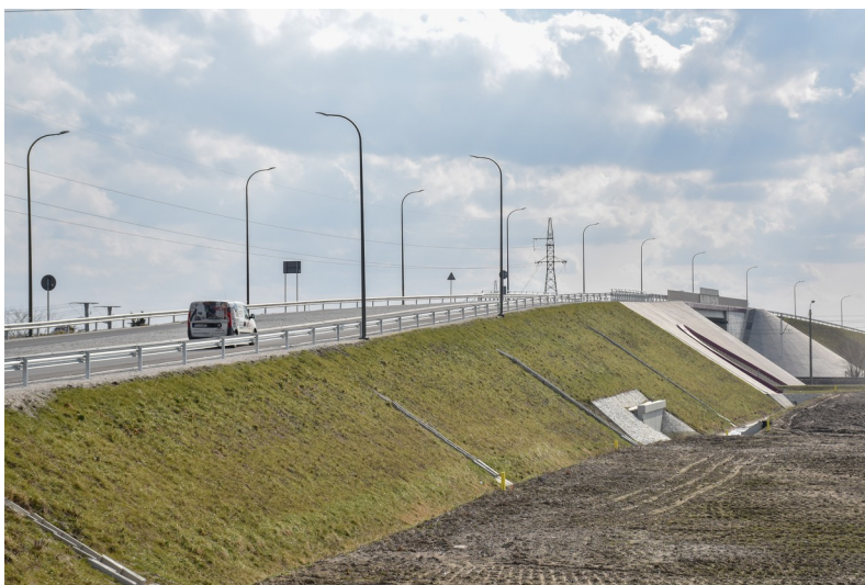
Nowo wybudowany wiadukt na wschodniej obwodnicy Wrześni
