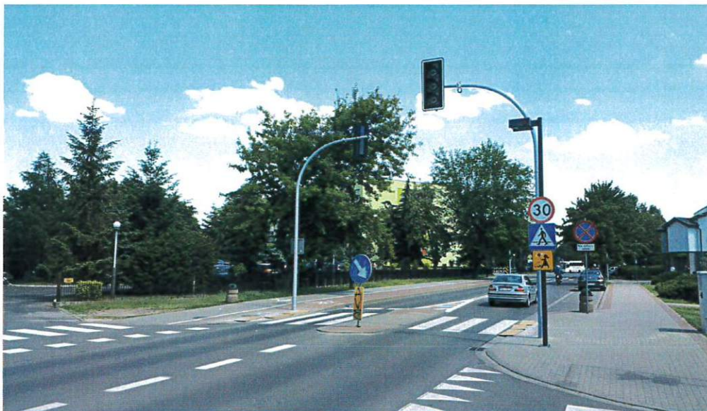
Przeście dla pieszych przy ulicy Słowackiego wraz z oświetleniem i sygnalizacją świetlną
