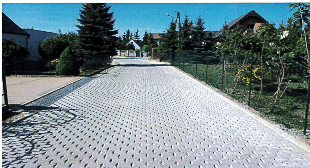
Nowa nawierzchnia na ulicy Wierzbowej w Bierzglińku
