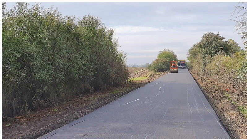
Przebudowa drogi Sokołowo - Sobiesiernie
