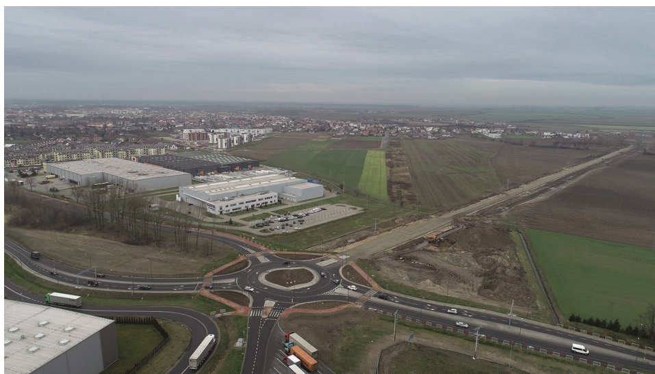
Nowo wybudowane rondo wraz z wylotami na DK 92
