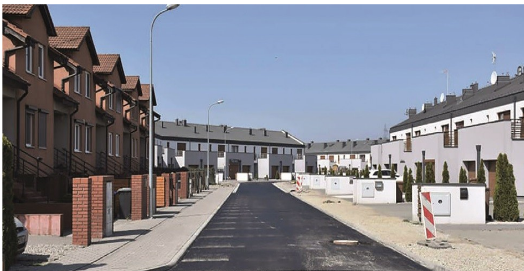
Budowa drogi przy ulicach Paderewskiego i Cyrkoniowej
