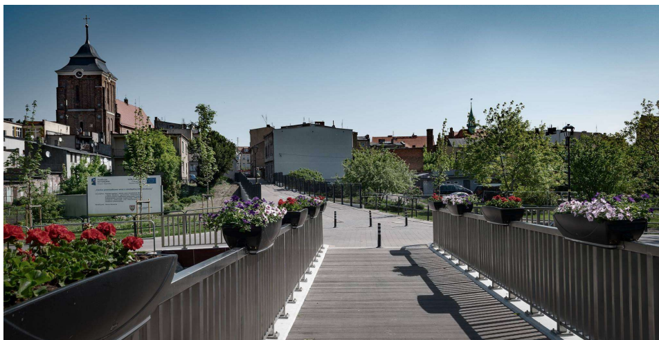
Nowa kładka na rzece Wrześnica wraz z modernizowaną ulicą Rzeczną
