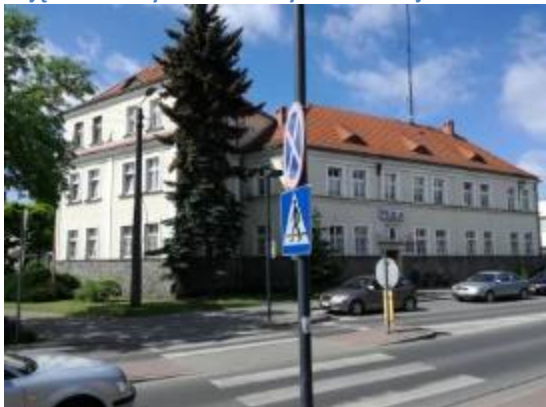
Zdjęcie 14 Budynek Komendy Powiatowej we Wrześni
